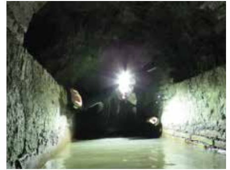
Fig. 13 – Tratto iniziale dell'acquedotto ipogeo del Cannellone (Bagnoregio).
