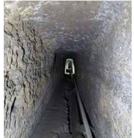
Fig. 14 – Acquedotto ipogeo del Cannellone (Bagnoregio).
