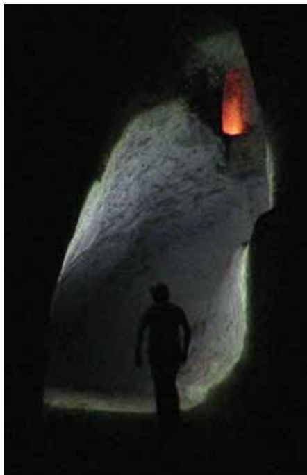
Fig. 12 – Tunnel tra Bagnoregio e Lubriano (grotta dei Ghiri): ramo morto visibile sulla volta del traforo, dovuta ad un errore nelle fasi di scavo.
