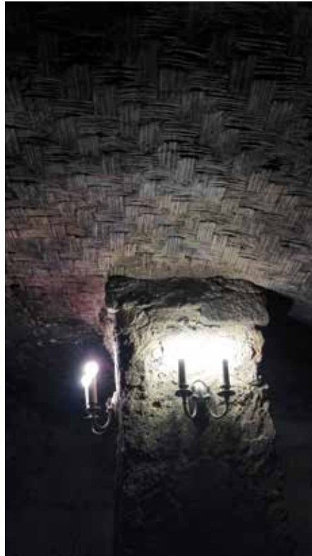
Fig. 11 – Sull'intonaco del soffitto ancora fresco a volte rimaneva impresso lo stampo dell'intreccio di paglia o cannuccia che veniva posta sopra la centina.
